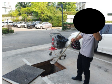
ภาพที่ 2.2-12 การสูบลากตะกอน ตักตะกอน ไขมัน
