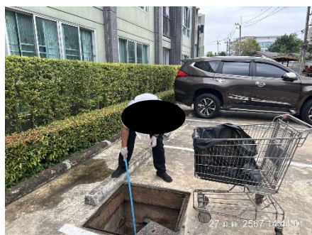
ภาพที่ 2.2-12 การสูบลากตะกอน ตักตะกอน ไขมัน
